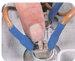
Thermostat de résistance à réarmement.
