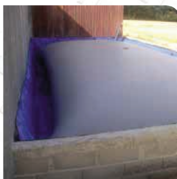
Rétention entre muret
